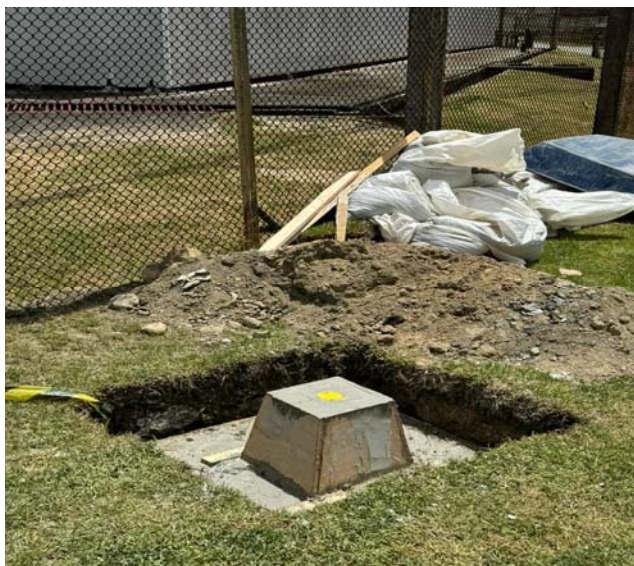
Figura 6.11- Execução do marco auxiliar AUX-06 para leitura dos marcos superficiais do talude. Atualmente, já concluída a execução.
