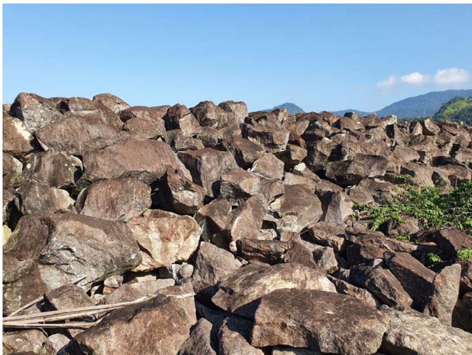
Figura 6.16- Detalhe dos blocos de rocha do molhe.
