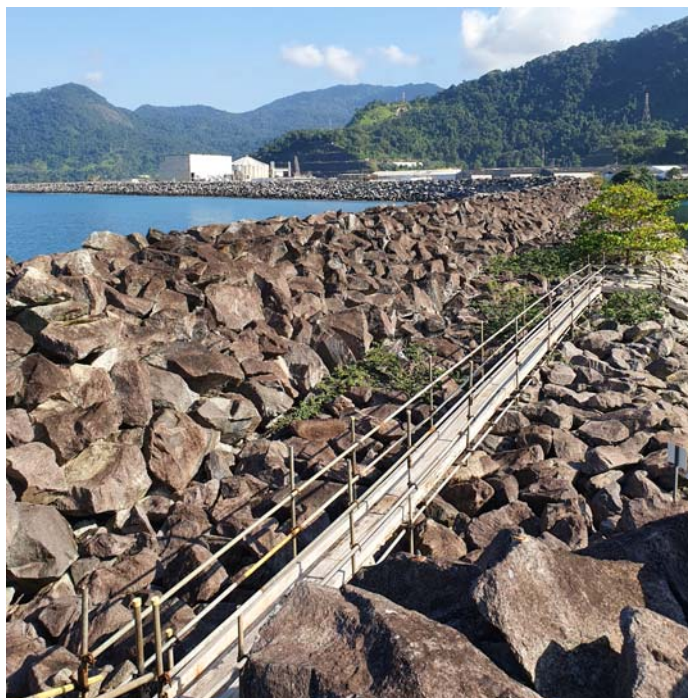
Figura 6.15 - Vista da porção leste do molhe, detalhe para a pequena passarela existente neste trecho.
